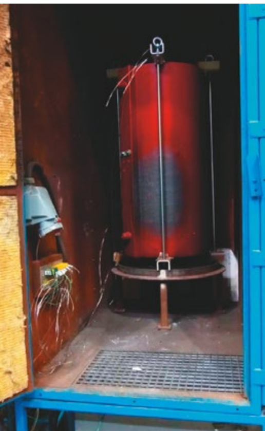
Fire Hazard Test
